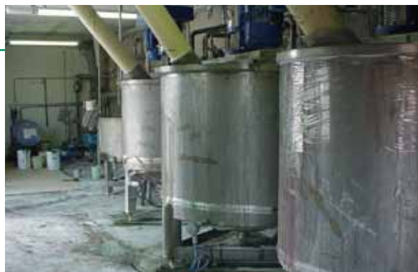
Area miscelazione resine
